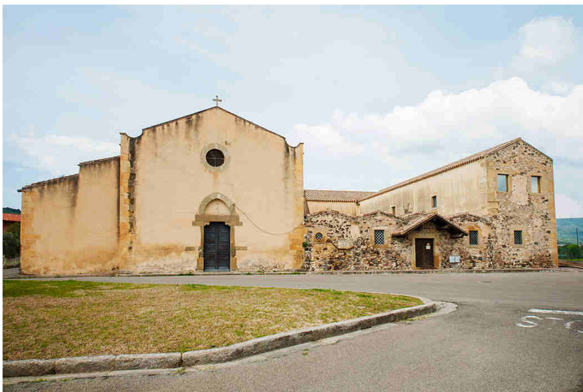
Fig. 5 - Convento di San Francesco, costruito nel 1646 e già sede dei frati cappuccini. Oggi, è sede del Museo dei minerali del Monte Arci (foto: Comune di Masullas)
